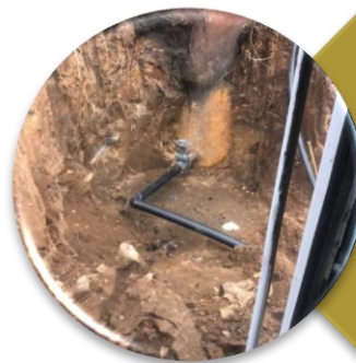
Частичный ремонт сети централизованного водоснабжения
